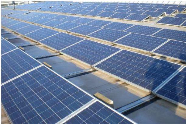
**Bild 5** ballastiertes System mit Grundschiene
