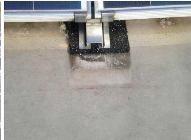
**Bild 8** Verschiebung der Bautenschutzmatte
