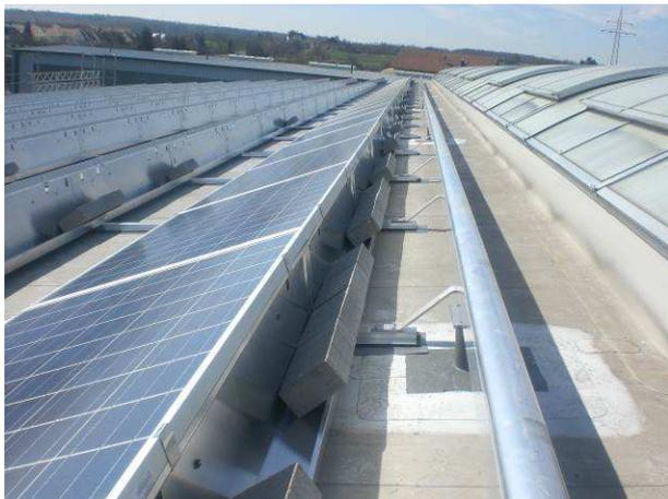
**Bild 14** Fixierung des Generators an Sekuranten
