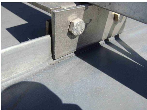
**Bild 1** Schaden am Stehfalzdach
