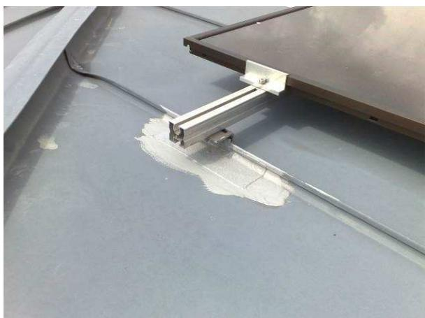
**Bild 3** Reparatur Stehfalzdach
