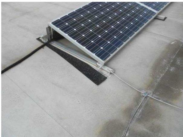
**Bild 16** verrutschte Bautenschutzmatte
