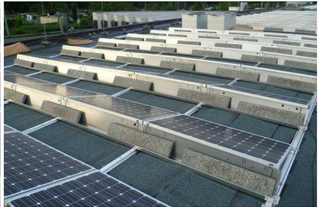
**Bild 6** Ballastierung mit Kantensteinen
