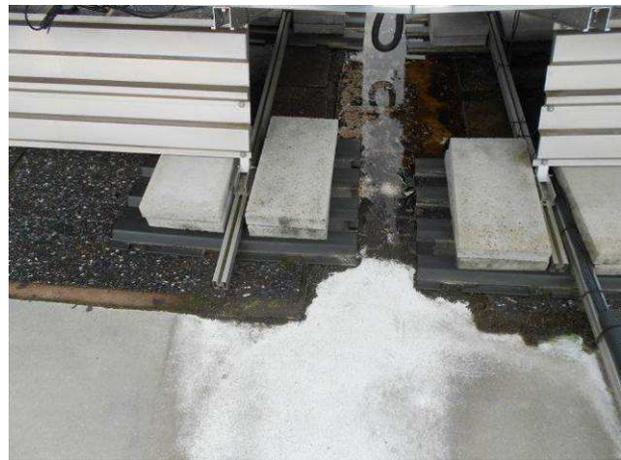
**Bild 10** Verschiebung auf der Bautenschutzmatte
