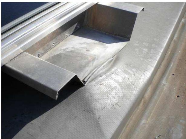
**Bild 11** Einschneiden des Gestells in die Dachhaut
