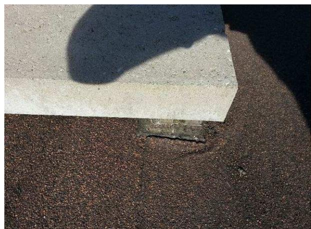
**Bild 12** Verschiebung einer Bitumenbahn
